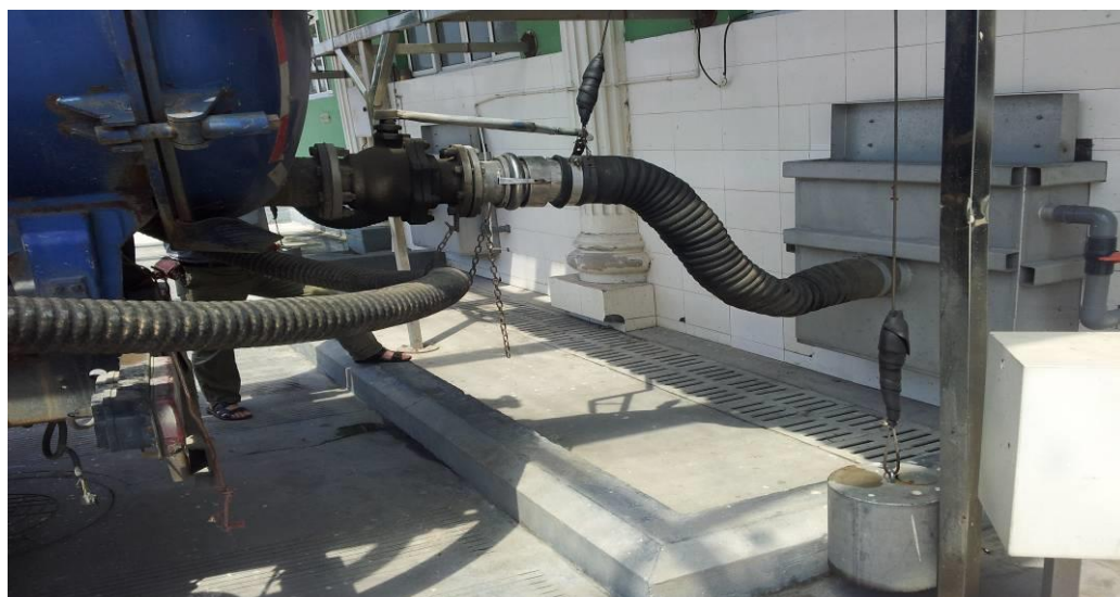
图 7.4-1 粪便卸粪间快速对接卸粪装置
